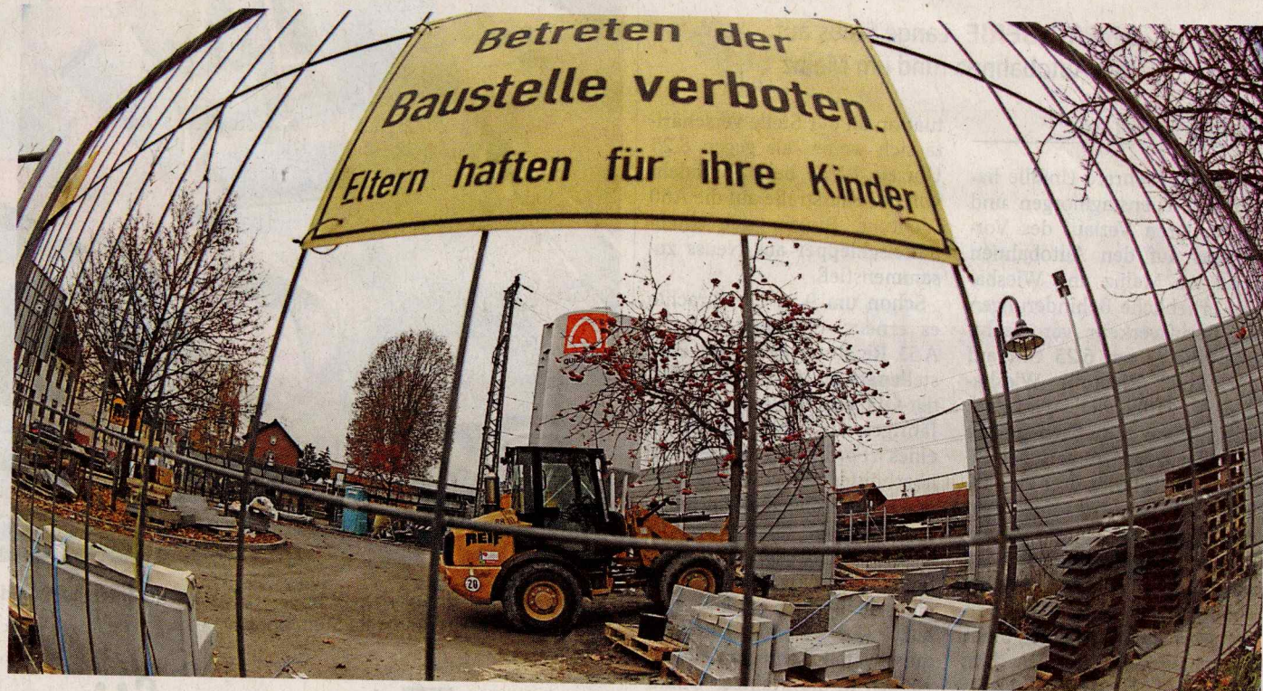
Ende Dezember sollen die Bauarbeiten am Bahnhof Bodenheim abgeschlossen sein.
